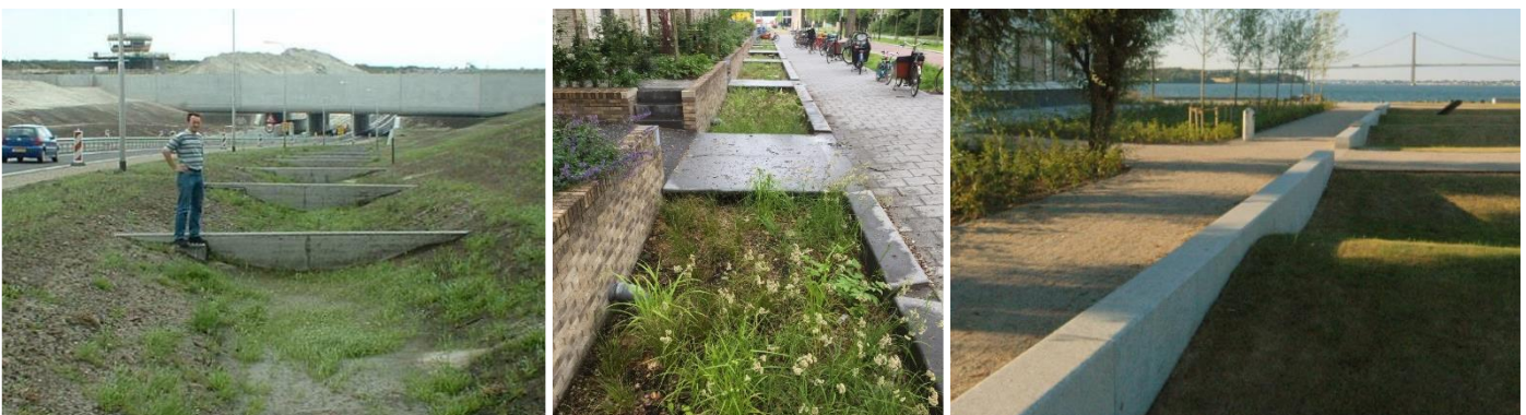
Figuur 38: Getrapte berging in wadi/infiltratiestrook, links: Naviduct Enkhuizen, midden: Kop Zuidas, Amsterdam (foto's: Climatescan.nl), rechts: locatie onbekend (foto: doelbeelden.nl)
