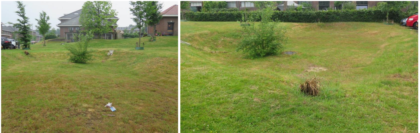
Figuur 30: Wadi's in een gebied met hoogteverschillen, Infanteriebuurt Arnhem (foto's:Climatescan.nl)
