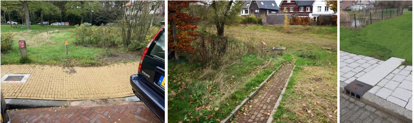
Figuur 32: Verlaagde band met groene goot naar wadi, Treubstraat Amersfoort, gestrate goot naar wadi, Regiment Pontonniers Arnhem (foto's: Climatescan.nl) en kolkgoot met afvoer naar wadi, Wielengenstraat Zoutelande (foto: Bleijko.nl)
