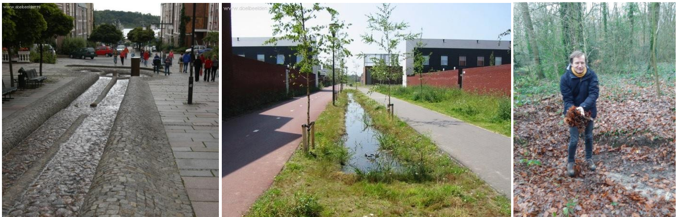
Figuur 34: Afvoer via goot (links), opvang in- en afvoer via infiltratiestrook (midden), locaties onbekend (foto's: doelbeelden.nl), opvang in infiltratiekuil (rechts) Klein Zwitserland, Amersfoort (foto: bergwater-amersfoort.nl)
