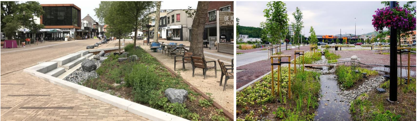
Figuur 33: Infiltratiestrook, links Grotestraat Nijverdal (foto: Climatescan.nl), rechts: Ålgård City Centre (foto: cfmoller.com)
