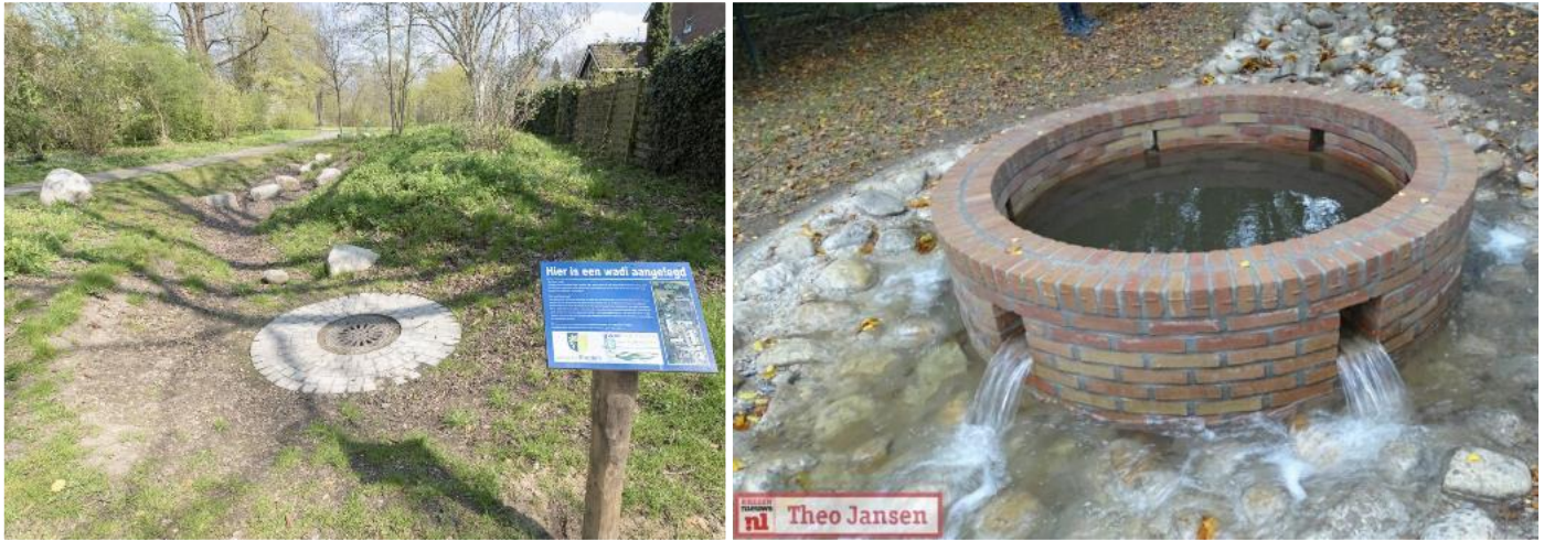
Figuur 27: Uitstroompunten vanuit een leiding naar een wadi, beide in Rhenen, foto's: Climatescan.nl
